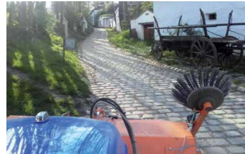
Die alte Pflastersteinrinne wurde freigelegt.
