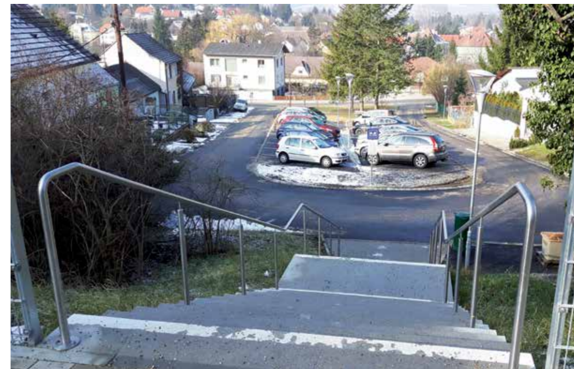
Die Park & Ride-Anlage wird von den PendlerInnen gut angenommen.
