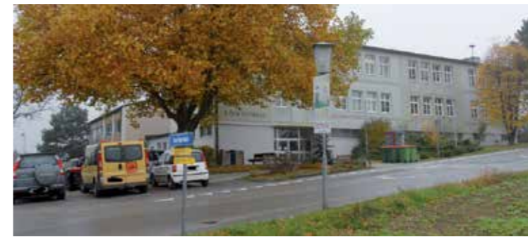
Die Umbauarbeiten an der Schule haben bereits Anfang April begonnen.
